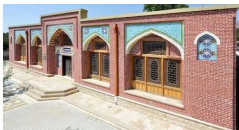
Şəkil 1. Qəysəriyyə bazarı son bərpadan sonra
