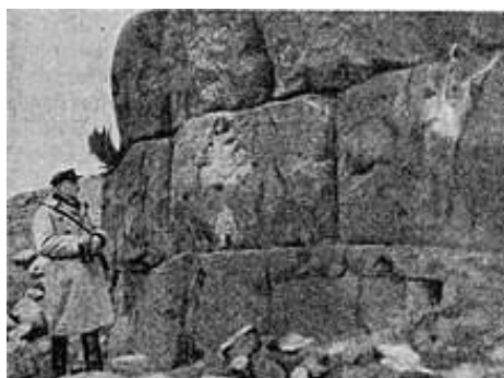
Рисунок 6. Крепость Оглан гала в Нахчыване, фрагмент циклопической кладки
